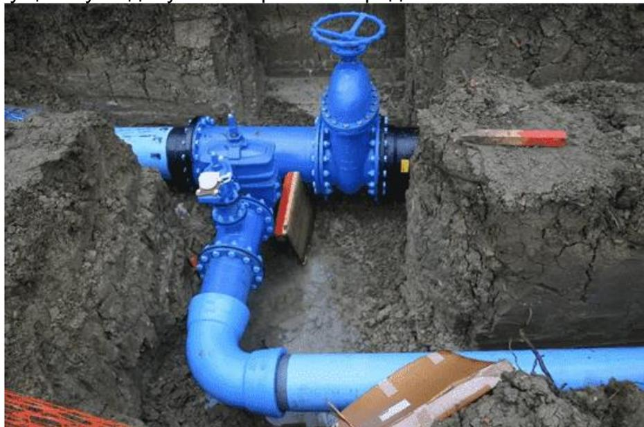
Рис.2 Готовый трубопровод
